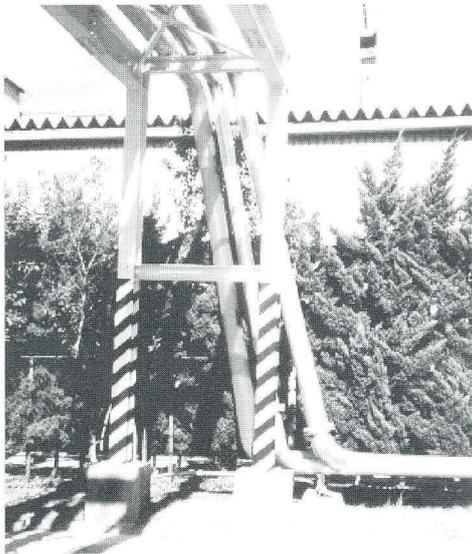
写真1 大きな水平方向相対変位を吸収した配管系
